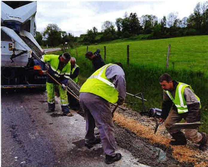
**RD 470 :** Des travaux importants ont été réalisés par la DDT (Direction Des Territoires). Un ensemble de fissures et un affaissement sont apparus au fil du temps, à la suite de l'usure ou de fatigue de la couche supérieure du revêtement routier. Du béton fibré a été coulé. Il est strié afin de prévenir les conducteurs qu'ils approchent du bord et éviter ainsi de nouvelles dégradations de la chaussée. Les vitesses trop élevées sont naturellement déconseillées.
