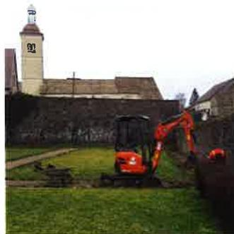
**TRAVAUX d'ASSAINISSEMENT dans le parc et « Aux genévriers » .** Une canalisation communale qui traverse la propriété de M. Mme d'Escienne a dû être refaite. Réfection de la chaussée suite à un affaissement de voirie qui risquait d'endommager un égout.
